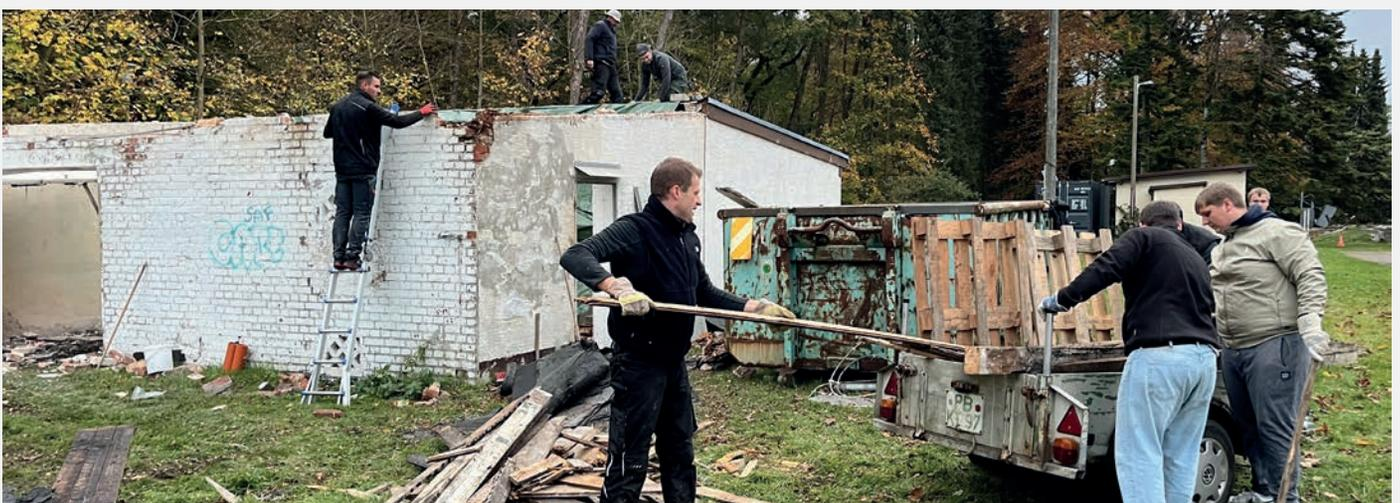
Vor dem Neubau kommt der Abriss: Gemeinsam wird das alte Dach der Garagen abgebaut, damit ein neues und dichtes Dach drauf kommen kann.
