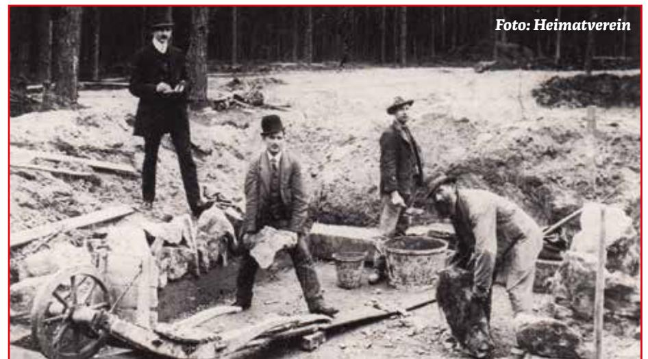
*Bauarbeiter mit Hut, Weste und Krawatte. So werden damals Fotos gemacht. Das Bild zeigt den Bau eines neuen Ablaufs. Damit wird das überfließende Wasser der Teichanlagen zur Strothe abgeleitet.*
